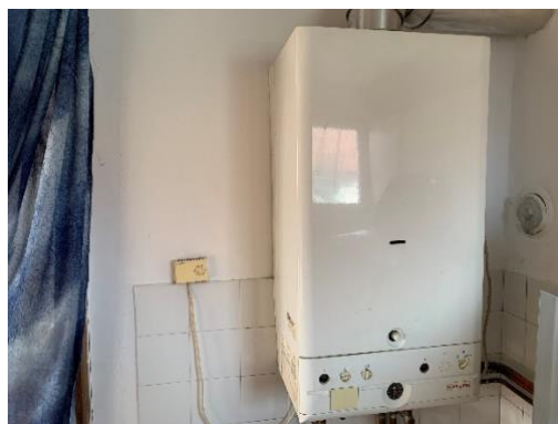
Slika 11. Prikaz plinskog bojlera
