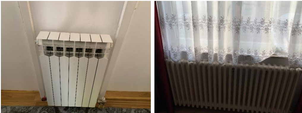
Slika 13: Prikaz aluminijskih rebrastih radijatora (lijevo) i gusanih radijatora (desno)
