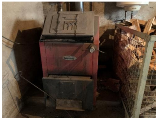
Slika 10: Prikaz toplovodnog kotla
