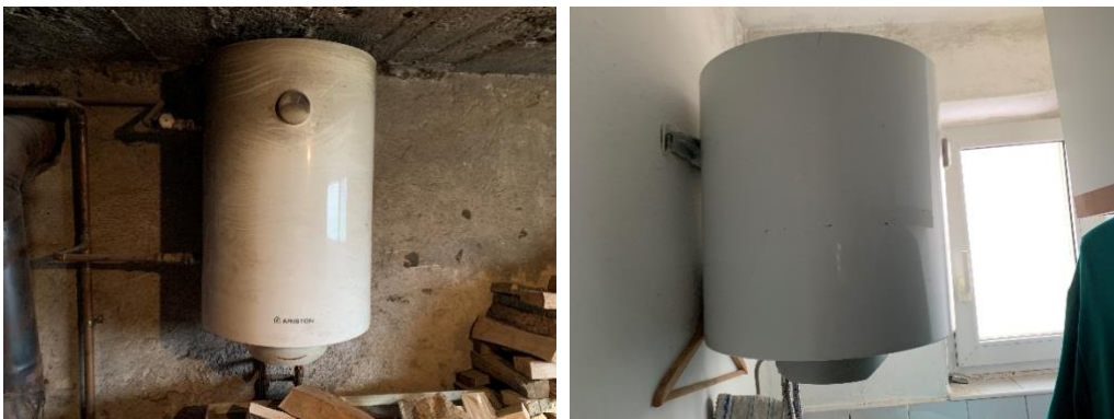
Slika 16: Prikaz bojlera za pripremu PTV
