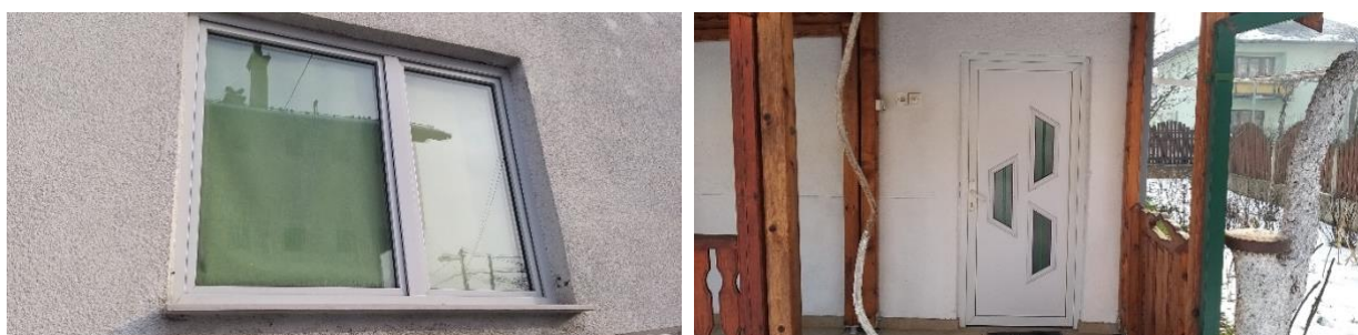
Slika 8: Prikaz PVC otvora na objektu
