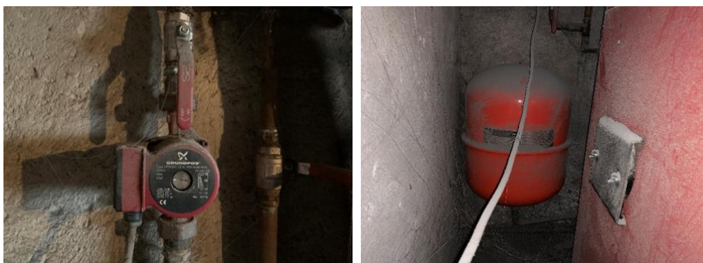
Slika 12: Cirkulaciona pumpa proizvođača „Grundfos“ i ekspanziona posuda
