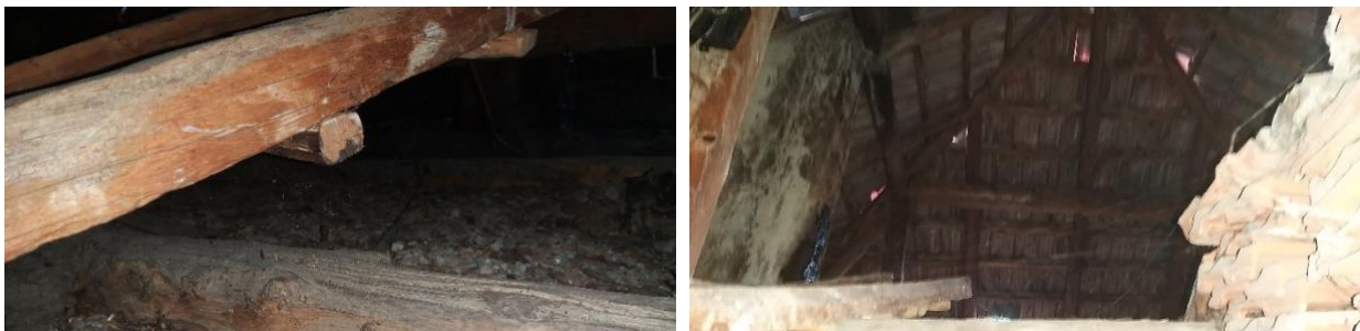
Slika 7: Stropna konstrukcija i negrijani tavanski prostor u objektu
