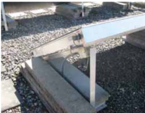
Slika 5.33: Stalci od aluminija su opterećeni betonskim elementima
