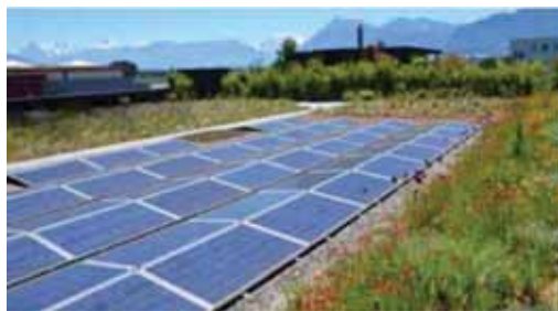
Slika 5.48: Energetski zeleni krov, energija iz sunca i zelenilo na istom krovu, pločaste staze čine FN sistem pristupačnim
