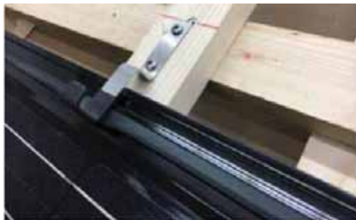
Slika 7.26: Kuke modula na okomitim letvicama. Gumeni rub omogućuje manje preklapanje
