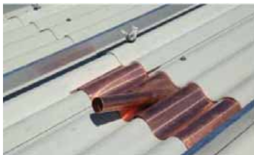
Slika 6.33: Proboj za bakarne valovite cementne ploče
