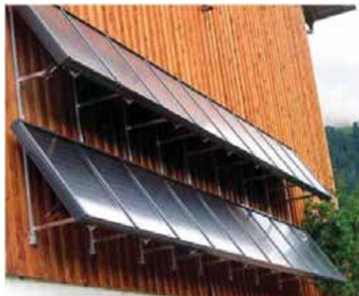
Slika 9.1: Rješenje za ravne kolektore ukošene na fasadu
