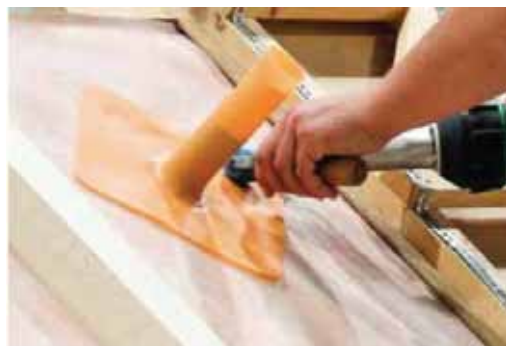
Slika 6.36: Manžetna za ulaz kablova kroz potkrov, termički zavarena
