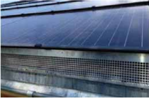
Bild 7.36: Perforirana ploča za ulaz ventilacije u području strehe
