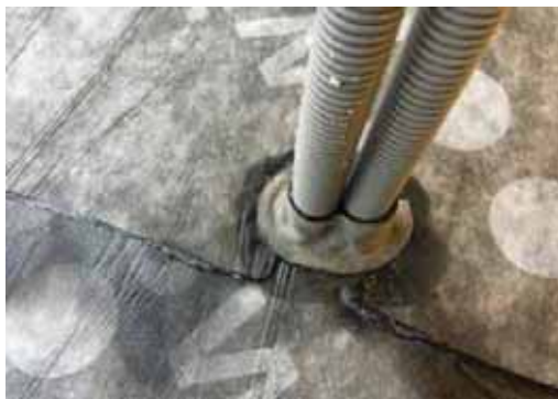
Slika 6.38: Spajanje s bitumenskom parnom branom
