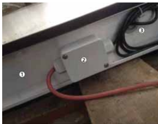
Slika 6.6: Kolektor sa senzorom i kutijom sa klemama
