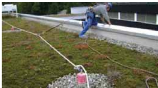
Slika 11.4: Osiguranje na ravnim krovu sa privremenim, linearnim sigurnosnim sistemom
