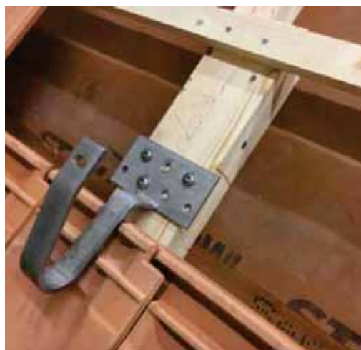
Slika 5.6: Bočnim postavljanjem kontra letvi, u području kuke za krov, mogu se postaviti i dodatni vijci, a (uz upit kod proizvođača sistema) mogu se koristiti i kraći vijci
