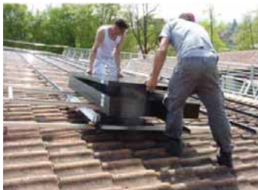
Slika 7.1: Sigurni transport modula na sistemu sa šinama
