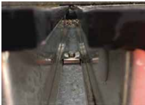
Slika 8.2: Fiksiranje u sredini dva kolektora
