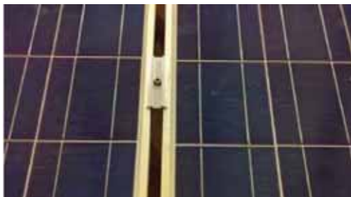
Slika 7.17: Držač modula u sredini
