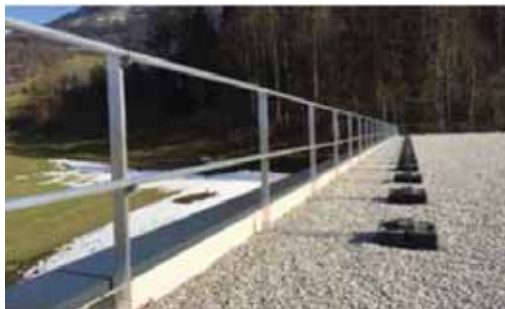
Slika 11.2: Privremeno osiguranje od pada na ravnim krovu
