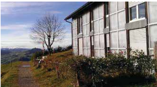
Slika 2.2: Fasada sa transparentnom toplotnom izolacijom na dograđenom dijelu objekta
