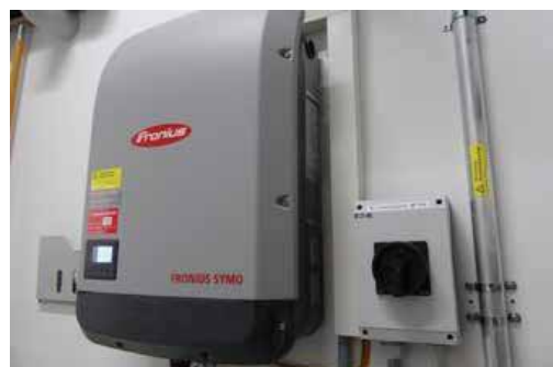
Slika 3.19: Multi serijski pretvarač sa rastavljačem na linijskoj strani
