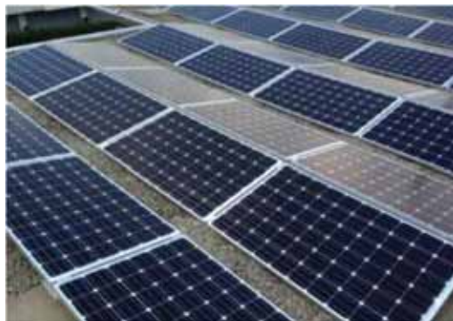
Slike 5.42 i 5.43: Instalacije FN sistema paralelno s krovom
