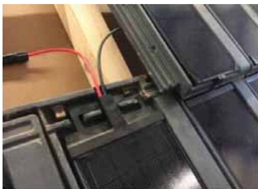
Slika 7.32: Moduli se direktno polažu na crijep i pričvršćuju stezaljkom na podlogu crijepa.
