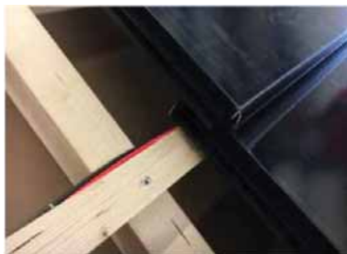
Slika 7.31: Moduli se prikače na krovne letve i stezaljkom pričvršćuju na letve
