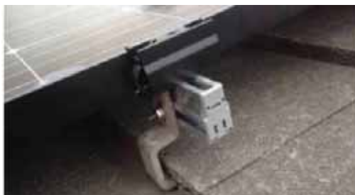
Slika 7.18: FN modul fiksiran sa klemom za kraj modula
