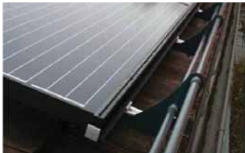
Slika 11.21: Snjegobran fiksiran na montažni sistem
