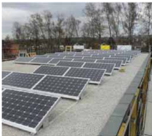
Slika 8.4: Montaža modula u sistemu ulijeganjem
