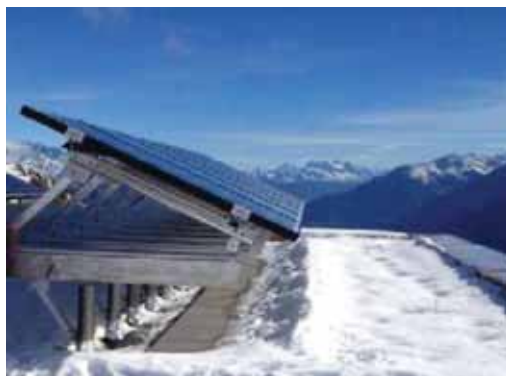
Slika 5.49: Montažni sistem za učvršćivanje u planinskim regijama
