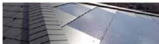
Slike 7.47 i 7.48: Rubni elementi od glatkog azbesta ili drugih prikladnih ravnih ploča od lima
