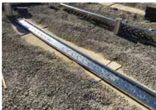
Slika 5.37: Noseći profil dizajniran za zaštitni sloj
