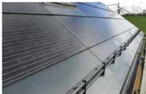
Slika 11.24: Snjegobran ispod FN sistema, pokrovni materijal sa sličnim izgledom kao FN moduli
