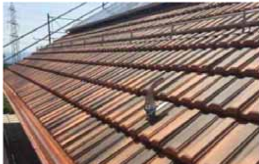
Slika 11.22: Snjegobran sa dovoljno razmaka od FN sistema iznad zone nadstrešnice
