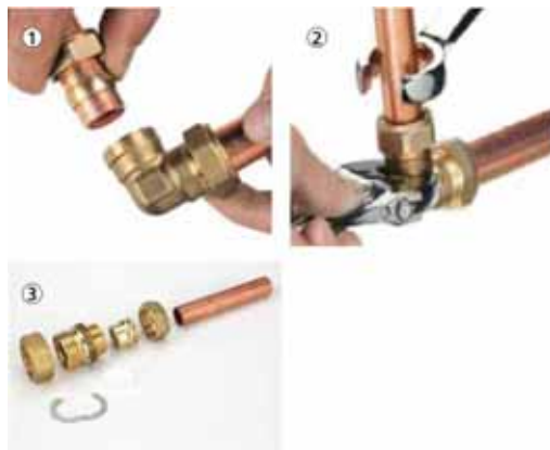
Slika 6.2: Spajanje bakarnih vodova
