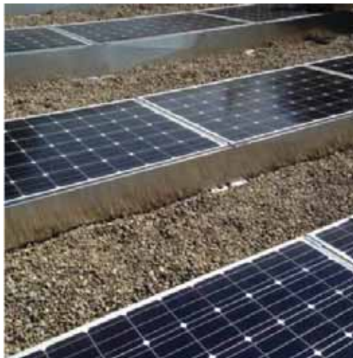
Slika 8.3: Montaža modula sa klemama i vjetrobranskim pločama od lima
