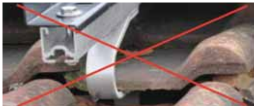
Slika 5.14: Glava i podnožje crijeva su potpuno uklonjeni. Ovo dovodi do ulaska vode.
