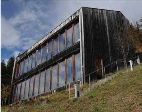
Slika 2.1: Pasivno korištenje solarne energije kroz prozore, na lokacijama bez magle
