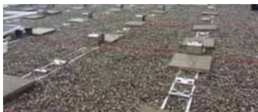
Slika 5.38: Noseći profil ispunjen šljunkom i balastiran
