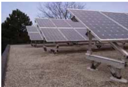
Slika 5.50: Prodirući sistem na industrijskom krovu
