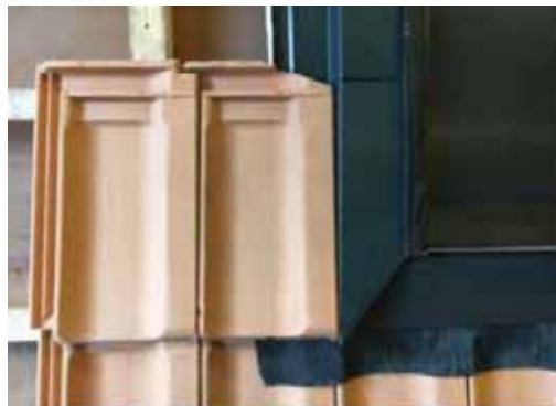
Slika 7.12: Priključak na pokrovni materijal
