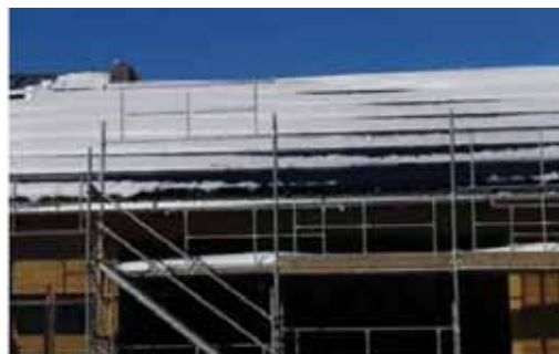
Slika 11.27: Lajsna za zadržavanje snijega na umetnoj šini. Rješenje za nagibe krova <math>< 20^\circ</math>
