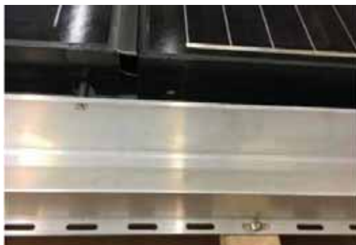
Slika 7.30: Pričvršćivanje modula na odvodni profil
