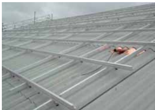
Slika 5.16: Podkonstrukcija od šina aluminijskih profila
