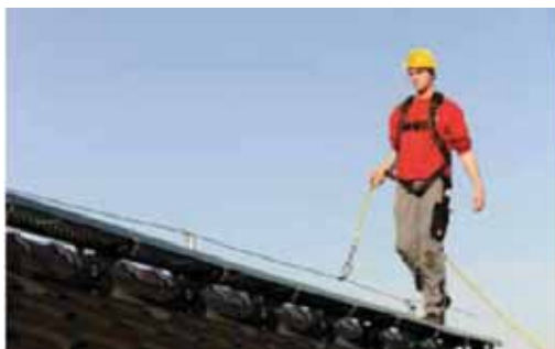
Slika 11.6: Sistem užadi na kosom krovu
