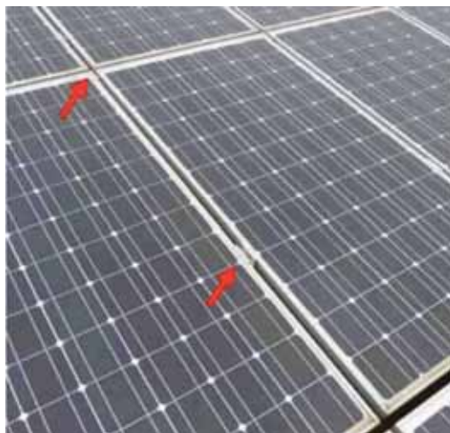
Slika 5.21: Problem: područje stezanja ne odgovara navodima dobavljača
