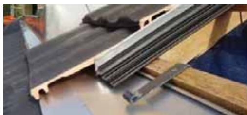
Slika 7.34: Prelaz s modularnog polja na pokrovni materijal. Verzija sa tankim limom
