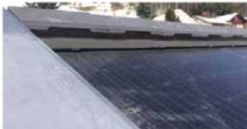
Bild 7.38: Ventilacija sljemena s kosim crijepom
