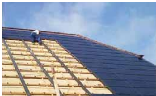
Slika 7.27: FN sistem sa kontinuiranim profilima
