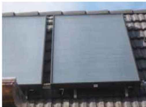
Slika 7.2: Pogled na pločasti (ravni) kolektor pri montaži na krovu
