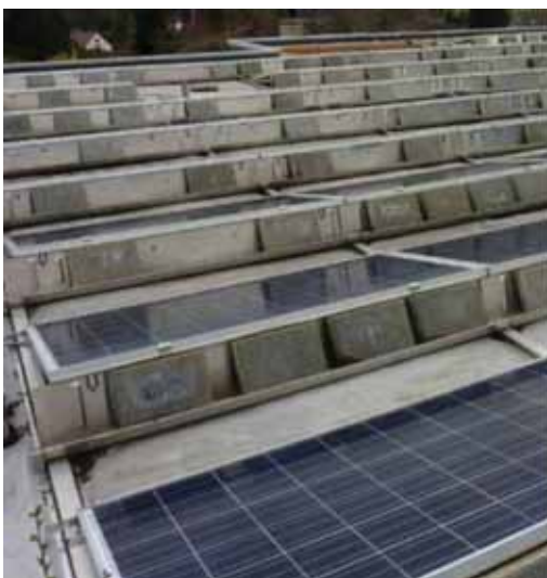
Slika 5.35: Betonske ploče kao balast
