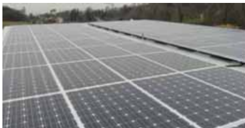
Slike 5.42 i 5.43: Instalacije FN sistema paralelno s krovom
