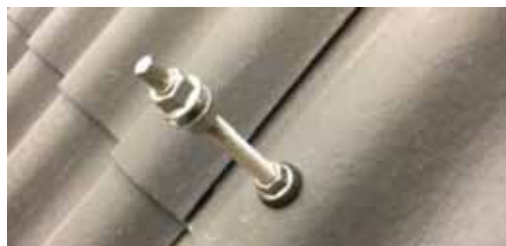
Slika 5.15: Montaža na valovitim azbestnim pločama sa visećim vijkom
