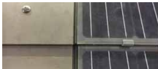
Slika 7.35: Prelaz s polja modula na pokrovni materijal, izvedba s ravnim pokrovnim materijalom, bez dodatne metalne folije
