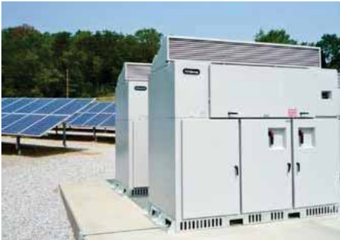
Slika 3.20: Centralni pretvarači/invertori
