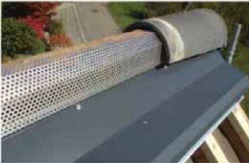
Slika 7.37: Perforirani lim kao sljemena ventilacijska rešetka sa okruglim crijepom na sljemenu
