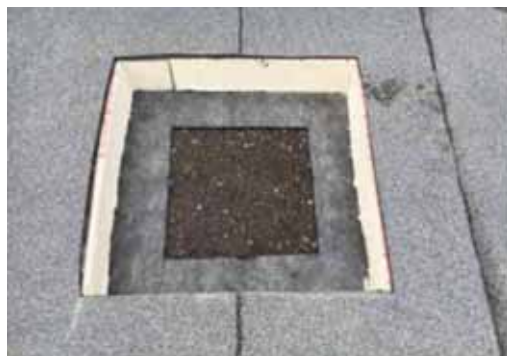
Slika 4.11: Ravni krov se otvara da su vidljivi svi slojevi i da njihovo stanje može procijeniti stručnjak, kontrolni otvor se nakon toga zatvara
