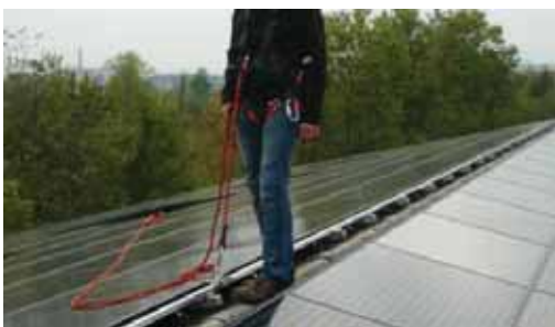
Slika 11.8: Sistem sigurnosti sa šinama na vrhu krovišta
