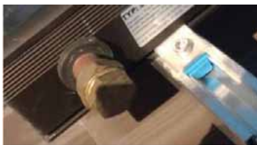
Slika 7.6: Pričvršćivanje kolektora bočno klemom na montažnu šinu; nosači bočno od kolektora se moraju još izolovati
