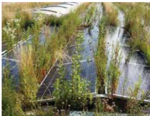
Slika 5.45: Nekompatibilni rast biljaka između FN modula
