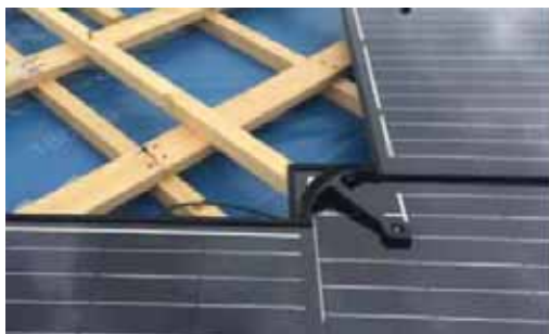
Slika 7.25: Montaža modula na dodatnim vertikalnim letvama. Pričvršćivanje se odvija kroz modul pomoću jednog vijka.
