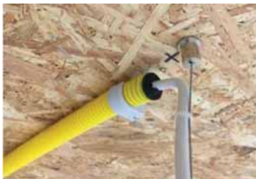
Slika 6.28: Gumeni čep sprječava razmjenu vazduha iz unutrašnjeg u spoljašnji ili hladni prostor u praznoj cijevi
