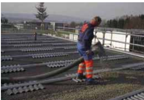
Slika 5.34: Balastiranje se može izvršiti nanošenjem zaštitnog sloja (okrugli šljunak ili substrat) ili polaganjem ploča
