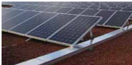
Slika 6.23: Metalni kablovski kanal za FN sistem
