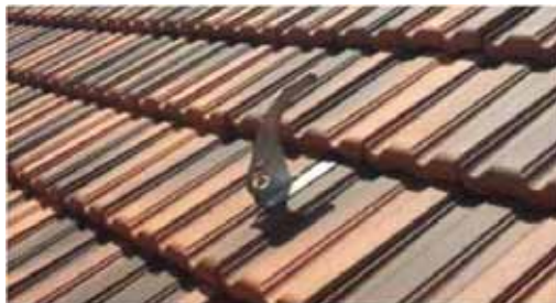
Slika 11.5: Sigurnosna kuka na kosom krovu
