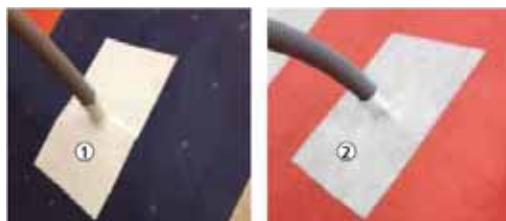
Slika 6.37: Različite varijante dihtovanja za kablovske ulaze kroz potkrov 1. Dihtovanje ljepljivom trakom (zavisno od sistema i proizvoda) 2. Dihtovanje samoljepljivim gumenim trakama
