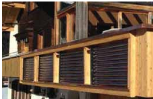
Slika 9.2: Rješenje sa vakumskim cijevima na fasadi
