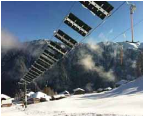
Slika 10.16: Kod snježnih padavina, moduli se mogu postaviti okomito kako se snijeg ne bi zadržavao na modulima
