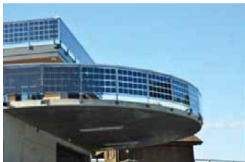
Slika 10.2: FN sistem kao balkonski parapet
