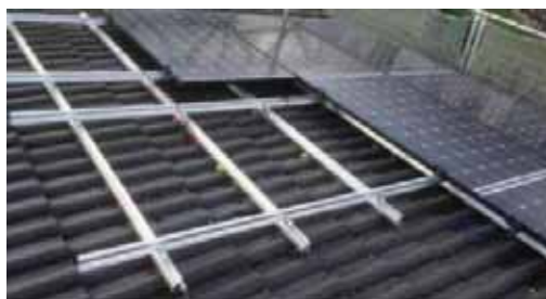
Slika 7.20: Križne prečke u horizontalnom rasporedu
