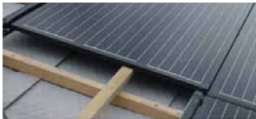
Slika 7.23: Horizontalni spoj skalirano preklopljen, vertikalni spoj dihtovan s plastičnim profilima
