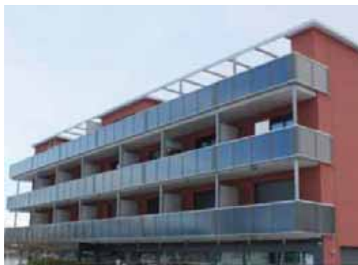
Slika 10.3: Solarni Kolektori za toplu vodu kao balkonski parapet
