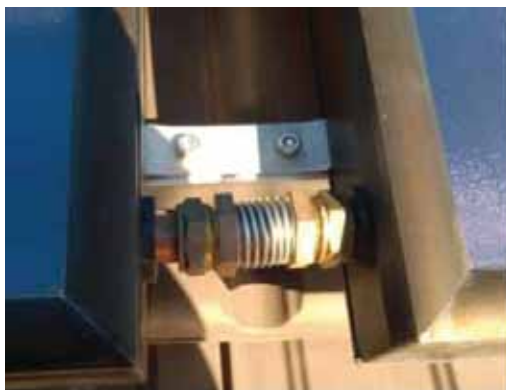
Slika 7.4: Fiksator kolektora sa fleksibilnim kolektorskim priključkom
