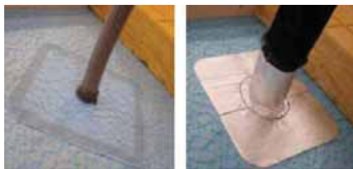
Slike 6.34 i 6.35: Proboj parne brane sa fleksibilnim crijevom (lijevo): priključak sa PE folijom i kaučuk trakom; i proboj parne brane za solarne cjevovode (desno): priključak sa dihtung trakom
