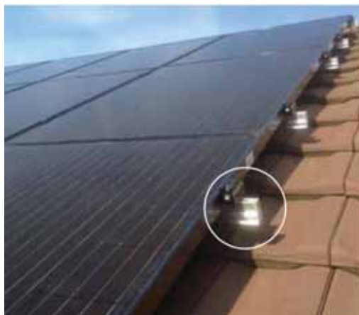
Slika 5.19: Montirani FN moduli. Područja stezanja su urađena po propisu (plavo područje na slici 5.18)
