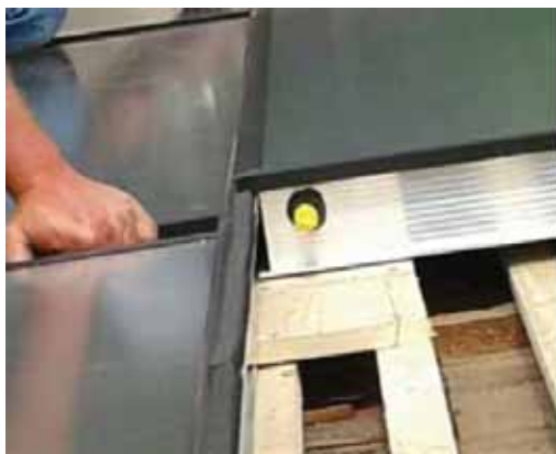
Slika 7.9: Preklapanje kolektora na vodoravnoj ravni sa izolacionom trakom za kiselinsku hidroizolaciju protiv kišnice
