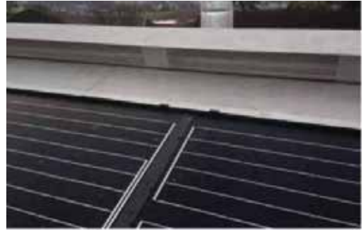
Slika 7.39: Sljemena ventilacija sa limom
