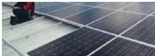
Slika 7.15: Sistem umetanja u aluminijum sa vertikalnom montažom modula
