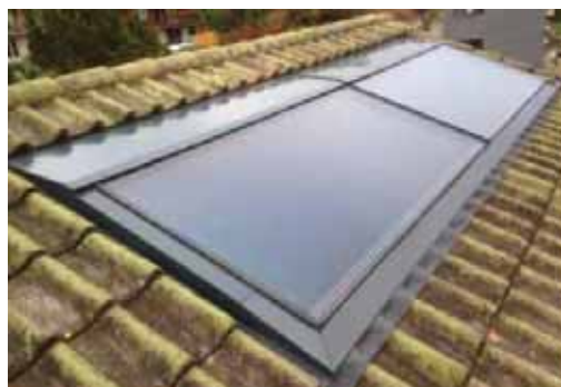
Slika 7.13: Limeni rubovi sa spojnim dijelovima na pokrovnom materijalu
