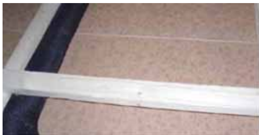
Slika 6.18: Vodovi u nivou s ventilacijom, paralelno s kontra letvom, ventilacija radi besprijekorno
