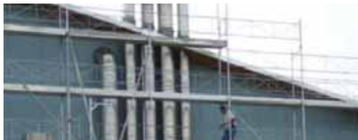
Slika 11.1: Fasadna skela kosi krov i fasada
