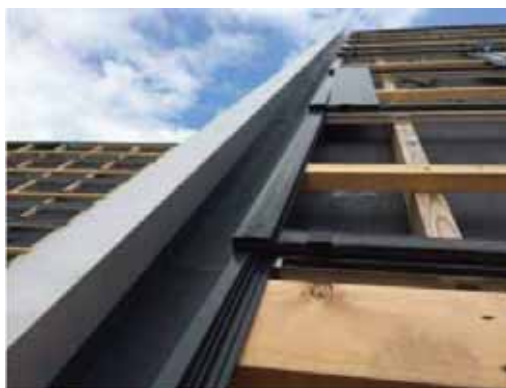
Slika 7.44: Lokalni završetak s oborenim lokalnim slivnikom
