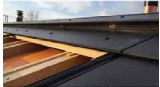
Slika 7.40: Sljeme i pokrovni materijal izrađeni od istog materijala
