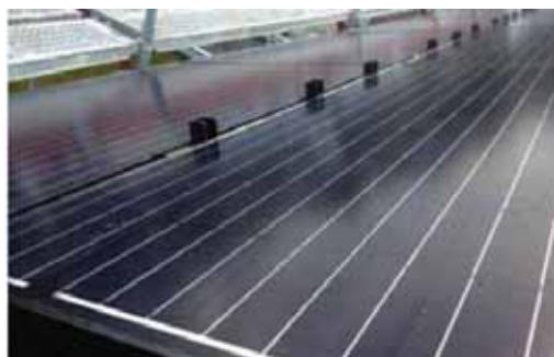
Slika 11.26: Zaustavljanje snijega kod sistema "na krovu"
