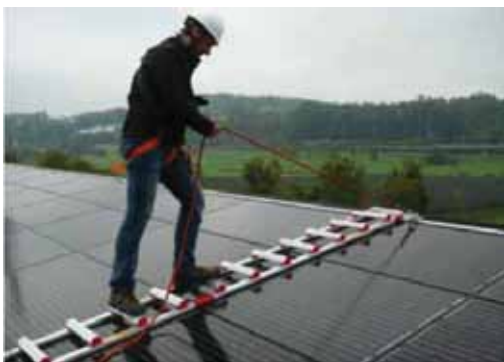
Slika 11.9: Specijalne krovne ljestve pričvršćene na šinu sigurnosnog sistema pri čemu FN moduli nisu opterećeni, jer ljestve nisu oslonjene na njih
