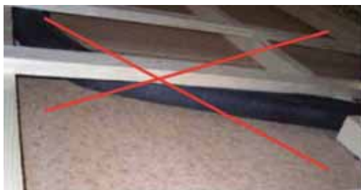
Slika 6.19: Vodovi koji vode preko kontra letvi mogu spriječiti prozračivanje u nedopuštenoj mjeri
