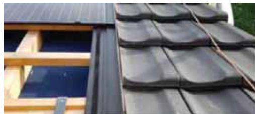
Slika 7.33: Bočni završetak (priključak) lima na krov
