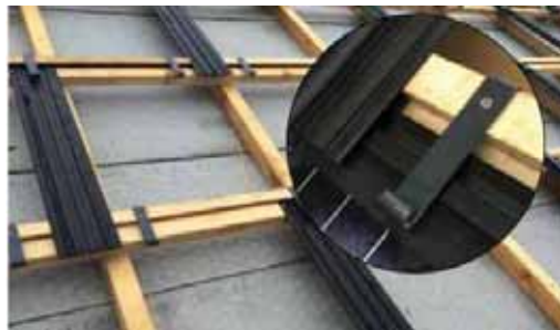
Slika 7.24: Letvice modula, fugni limovi i kuke modula. Ovim sistemom mogući su kontinuirani, ali i stepenasti spojevi
