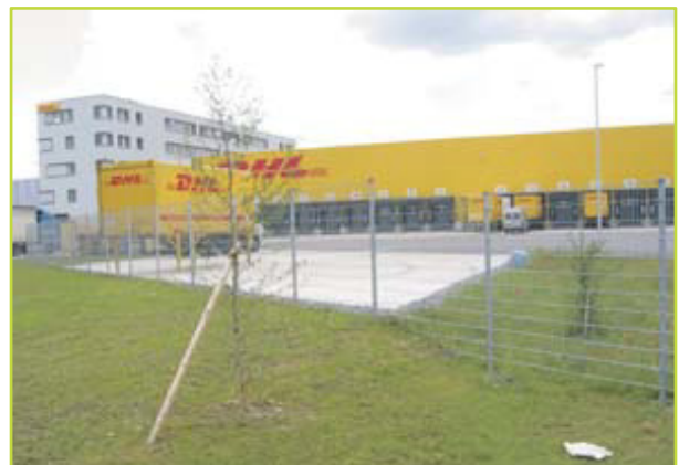
Slika 22. Na prostoru od 33'500 m 2 zemljišta koje pripada Express DHL-u u Regensdorfu se zelena površina dvostruko koristi: za uređenje prostora u skladu sa okolinom i za infiltraciju oborinskih voda sa krovova i površina oko objekta
