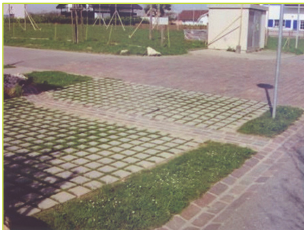
Slika 19. Infiltracija kod uređenja dvorišta
