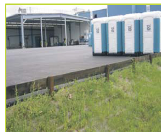
Slika 25. Oborinske vode sa velikih skladišnih površina firme TOI TOI u Buchsu površinski se odvođe do infiltracijskih udubina.
