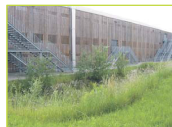
Slika 27. Kišnica sa krova dvorane za sportove na ledu se odvodi u infiltracijsku jamu koja je iz sigurnosnih razloga ograđena žicom.
