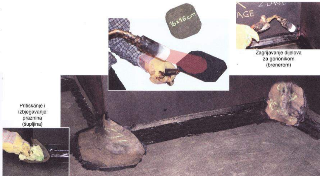
Izbočeni uglovi, postavljanje prvog sloja podloge
