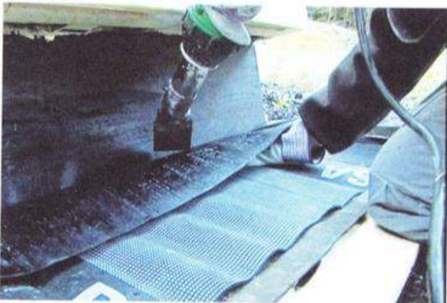
Polimer-bitumenske izolacijske staze – varenje sa vrućim zrakom, primjena u lako zapaljivoj okolini
