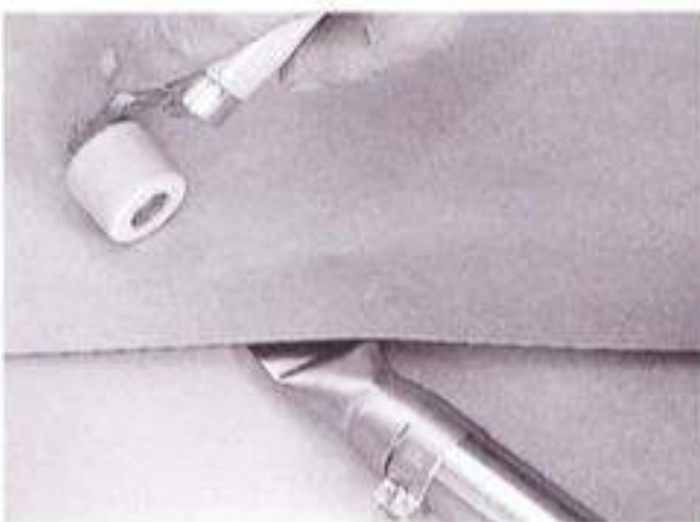
Priprema za varenje (pravljenje džepova)
