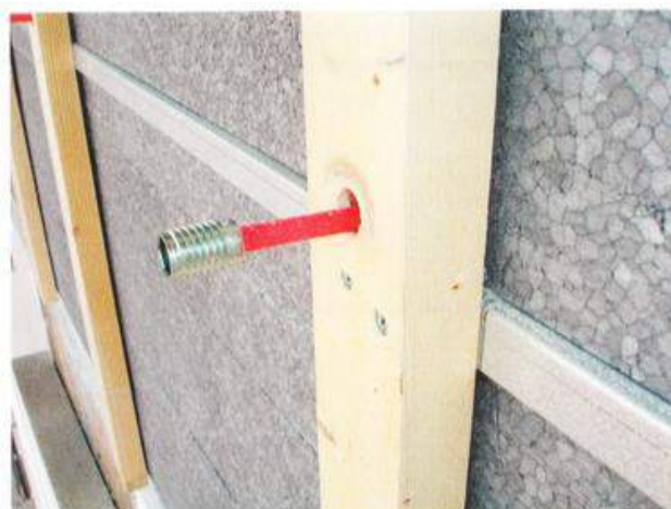
Definitivno fiksiranje sa sigurnosnim vijkom koji ima navoje s obe strane
