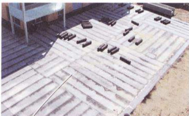
Zalijepljene staze na cijeloj površini
