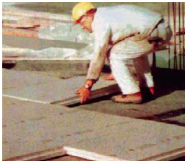
Korištenje poliuretanskih ploča od tvrde pjene u pokrivanju ravnog krova
