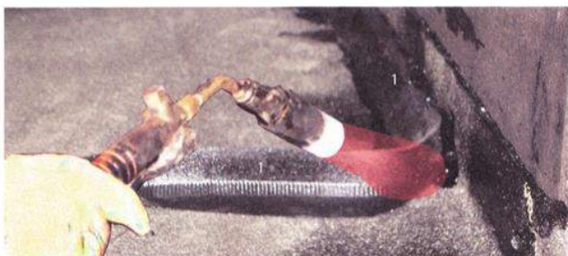
Formiranje užljebljenja: elastomerni klin
