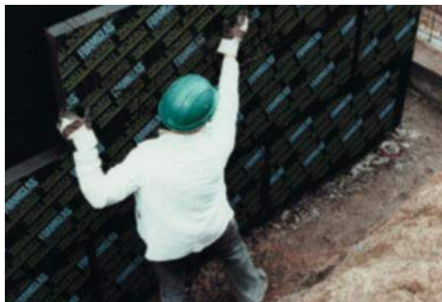
Upotreba ploča od pjenušavog stakla ka perimetar-izolacija
