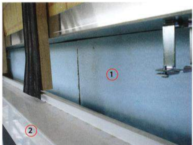
Izolacija natprozornika sa ekstrudiranim polistriolom (1), profil natprozornika (2)
