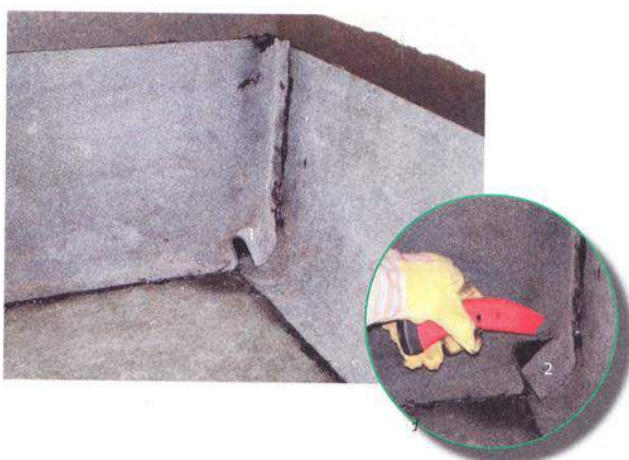
Izbočeni ugao Obostrano zalijepiti i formirati prelomnu faltnu (1), Urezivanje prelomne faltne (2)
