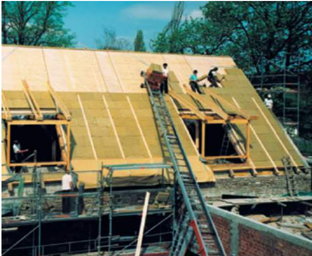
Toplotna zaštita na krovu
