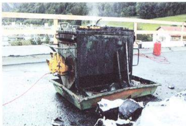
Zagrijavanje bitumena Bitumenska peć, gorionik /brener/ (žuta boja), Posuda za skupljanje, Bitumenski blokovi (bijela boja)
