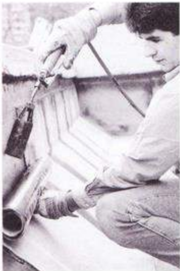
Varenje plamenom na vertikalnim površinama
