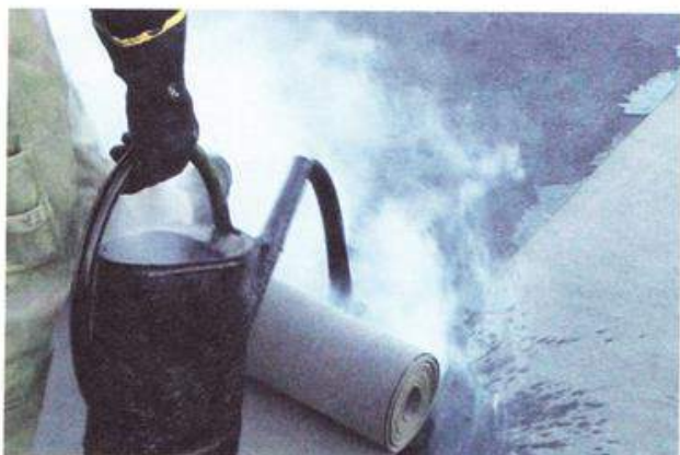
Vrući bitumen – izlijevanje i raspoređivanje
