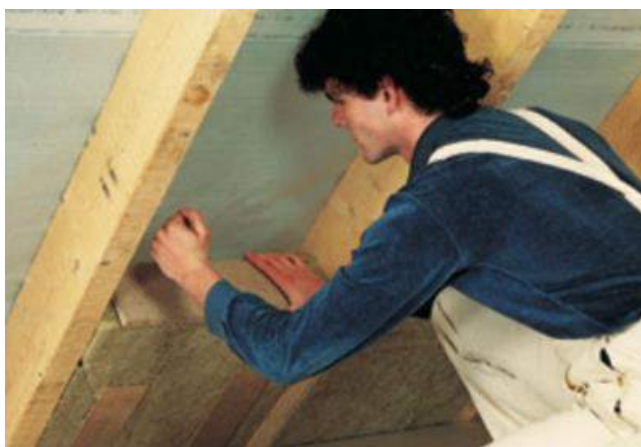
Ugradnja ploča od mineralne vune u izolaciji između rogova
