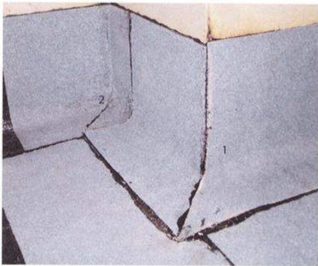
Podloga drugi sloj gotov Uvučeni ugao (1), izbočeni ugao (2)
