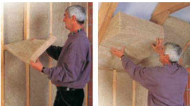
Ugradnja flisa od konoplje u drvenom okviru i kod izolacije između rogova
