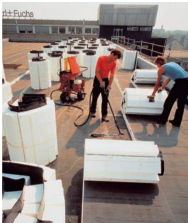
Izolacijska staza u roli od polistirola na ravnom krovu
