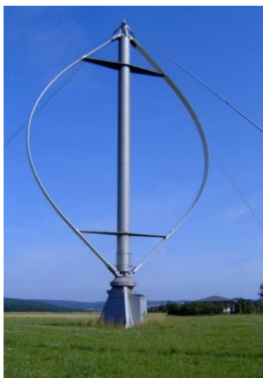
Slika 7.2. Darrieusova turbina
