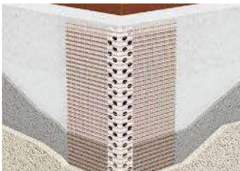
Slika 29. Postavljanje ugaone lajsne
