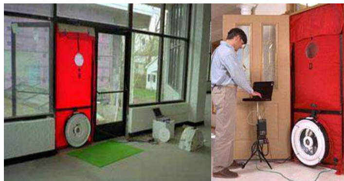
Slika 59. “Blower door” ventilator
