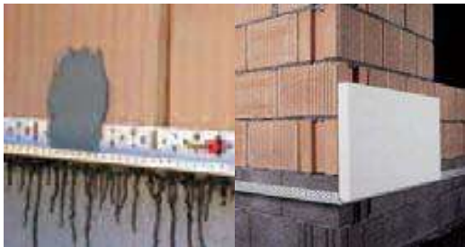
Slika 27. Postavljanje početnog, soklenog profila
