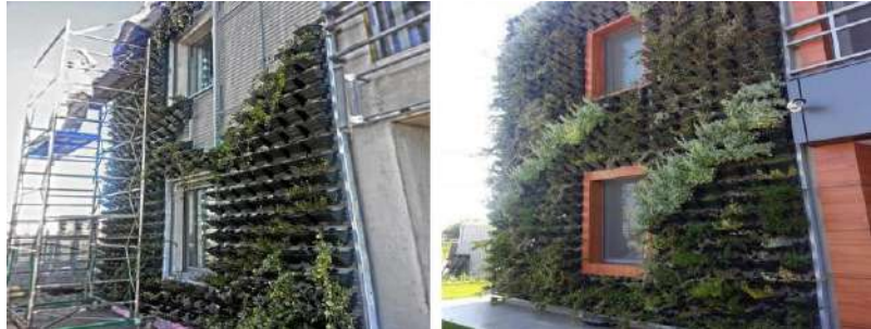
Slika 83. Montaža fasadnog kasetnog zelenog zida na metalnu potkonstrukciju
