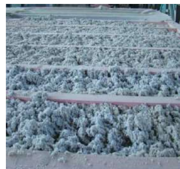
Slika 46. Izolacija poda eko pamukom
