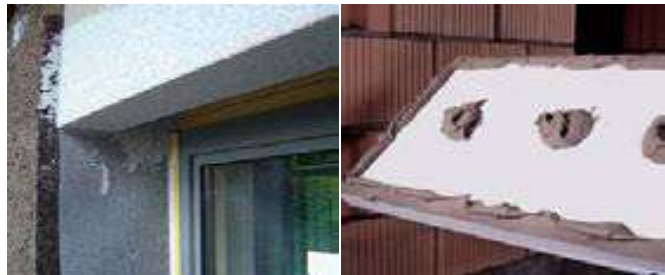
Slika 28. Nanošenje ljepila na stiropor ploče
