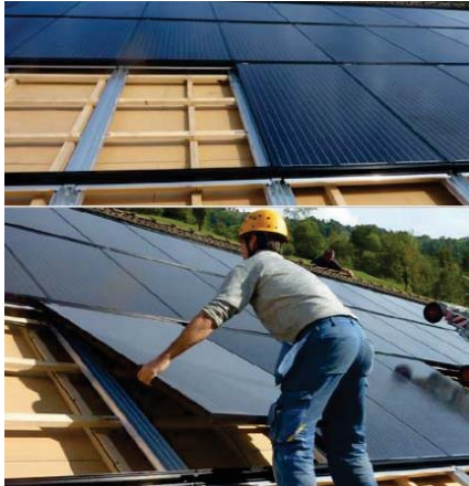
Slika 151: Ulaganje panela sa okvirom, Samuel Summermatter, BE Netz AG
