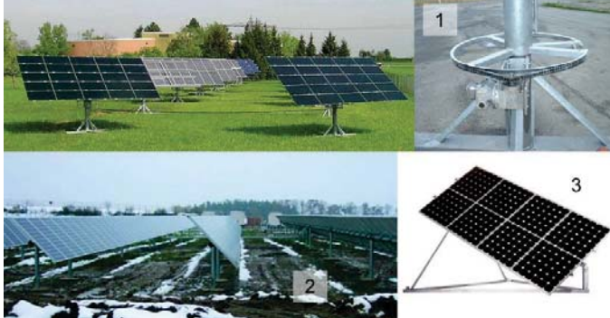
Slika 163: Jednoosovinski prateći sistem, Samuel Summermatter, BE Netz AG
