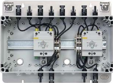
Slika 92: GAK bez osigurača www.aflury.ch
