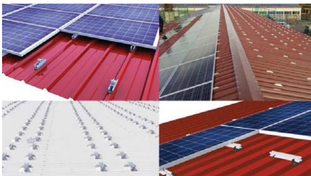
Slika 145: Konstrukcija bez šina www.altec-metalltechnik.de / www.k2-systems.ch
