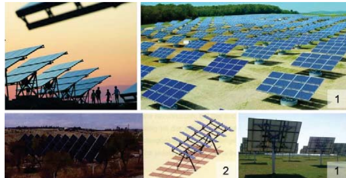
Slika 164: Dvoosovinski prateći sistem, Samuel Summermatter, BE Netz AG
