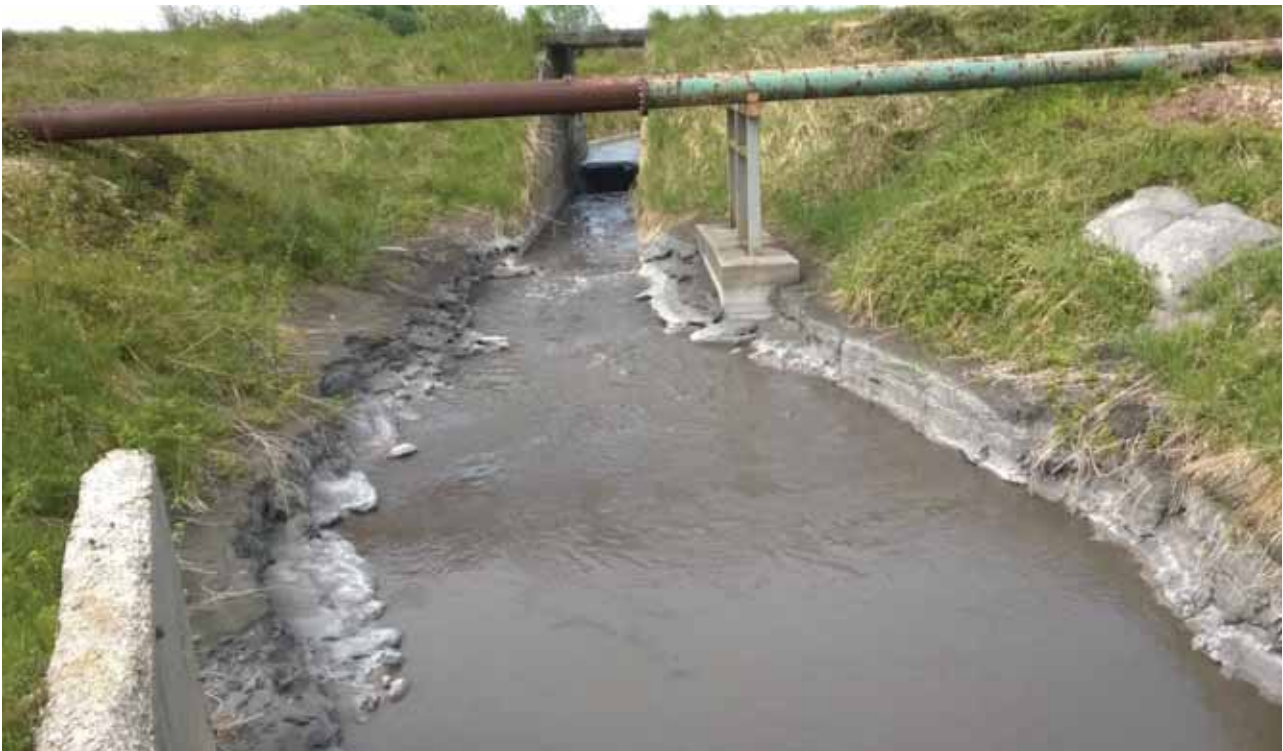
Slika 1.5. Dio obodnog kanala odlagalište šljake i pepela „Plane“, „Divkovići I“ i „Divkovići II“ (izvor: CEE arhiva)
