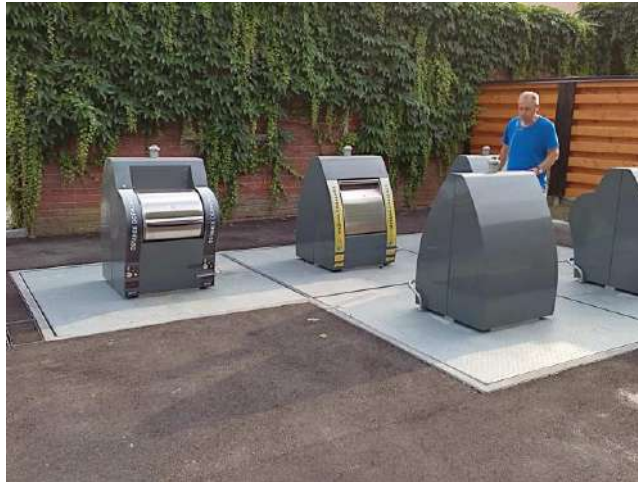
Slika 10. Podzemni kontejneri za selekciju otpada
