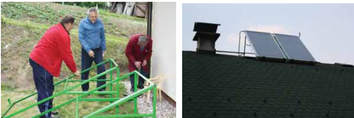
Slika 2.13. Pripremljeni nosači za dva solarna panela
