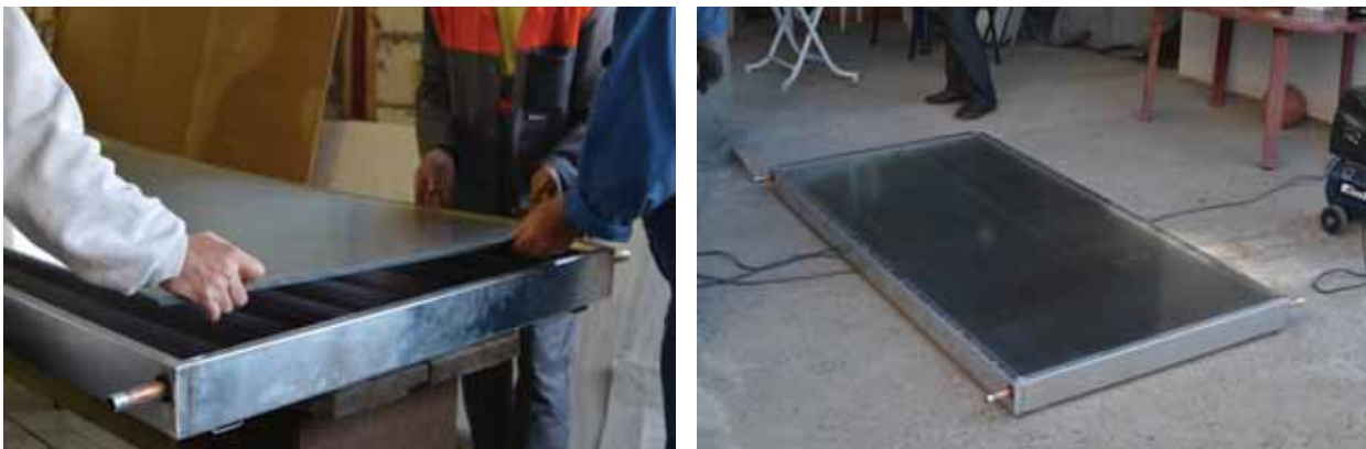
Slika 2.10. Staklo se pažljivo postavlja na kućište i završeni pločasti kolektor
