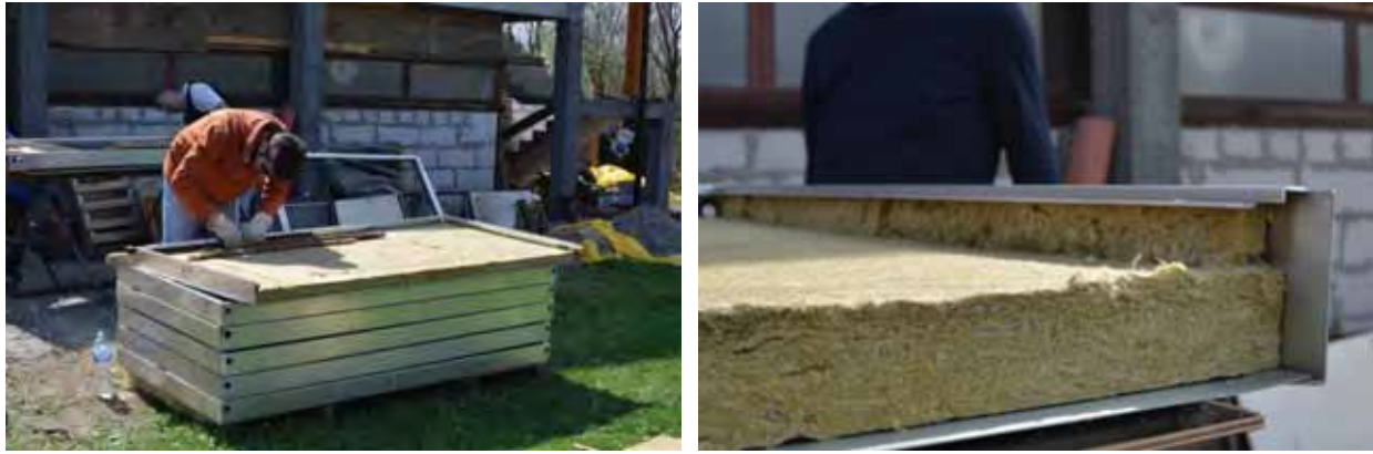
Slika 2.9. Izoliranje kućišta i stranica panela i detalj ispravno postavljene izolacije
