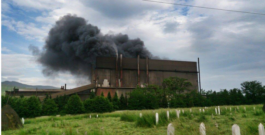
Slika 2.13.: Od 2008. godine, svakih sat vremena kroz krov pogona BOF čeličane ispuštaju se dimni plinovi
