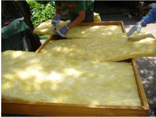
Slika 4.31. Postavljanje izolacione ploče od staklene vune
