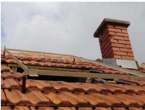
Slika 5.6. Čelično kućište spremno za instaliranje panela
