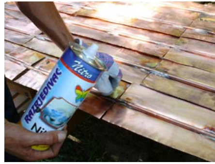
Slika 4.29. Čišćenje nitro-razređivačem prije farbanja
