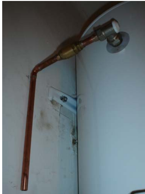
Slika 5.23. Gornji izlaz izmjenjivača sa ventilom
