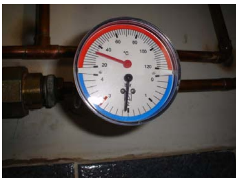
Slika 5.24. Termometar/barometar u sistemu
