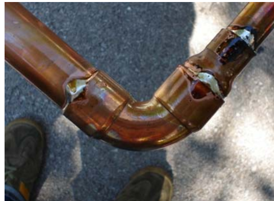
Slika 4.19. Lemljenje bakarne redukcije 22/15 mm
