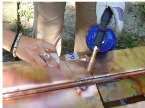
Slika 4.27. Lemljenje bakarnih krila za cijevi
