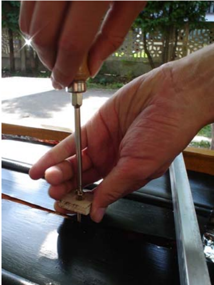
Slika 4.36. Drveni držači za providni prekrivač panela
