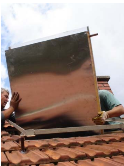
Slika 5.7. Montaža panela na čelično kućište
