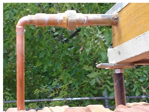
Slika 5.13. Montirani holender na donjoj cijevi
