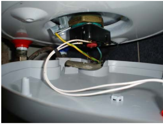
Slika 5.21. Priključenje bojlera na električnu struju
