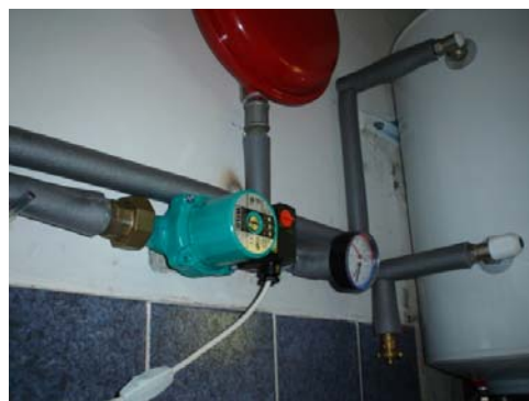
Slika 5.34. Izoliranje dijelova oko bojlera
