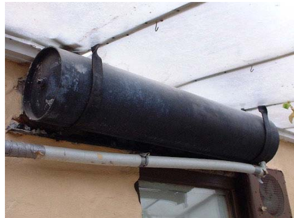
Slika 3.29. Najjednostavniji solarni kolektor
