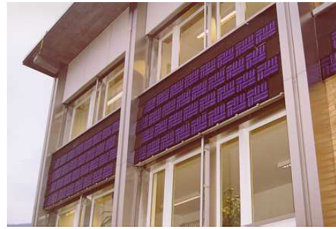
Slika 3.21. Solarno napajanja jedne škole
