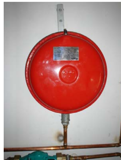
Slika 5.26. Ekspanziona posuda zapremine 5 litara
