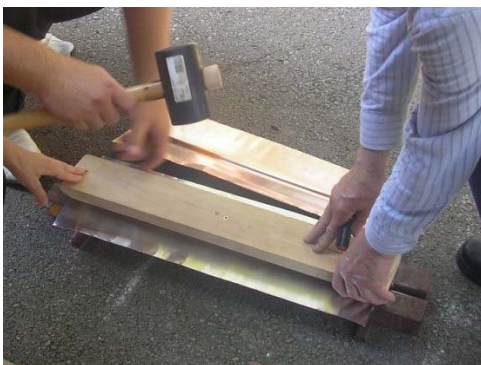
Slika 4.24. Pravljenje utora na limenim kriticima
