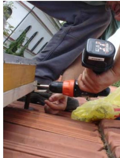
Slika 5.8. Učvršćivanje panela na kućištu
