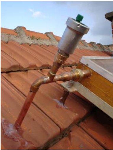
Slika 5.14. Montirani holender na gornjoj cijevi
