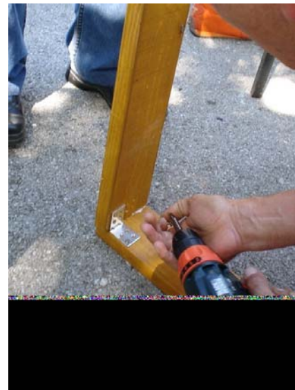
Slika 4.5. Praktično je koristiti L-učvršćivače
