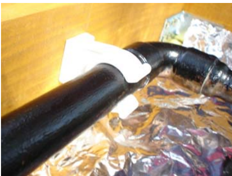
Slika 4.32. Montiranje plastičnih nosača
