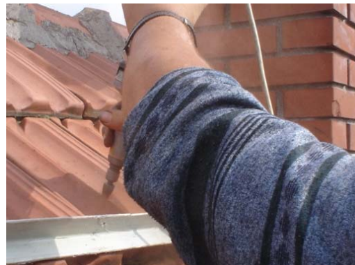
Slika 5.4. Bušenje crijepe radi provlačenja cijevi i šarafa
