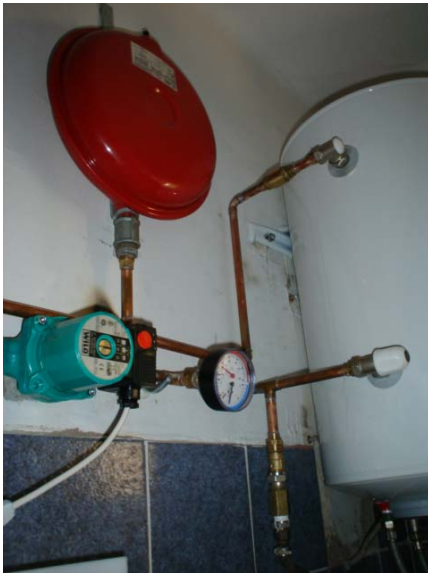
Slika 5.27. Zatvorena petlja – detalj oko bojlera
