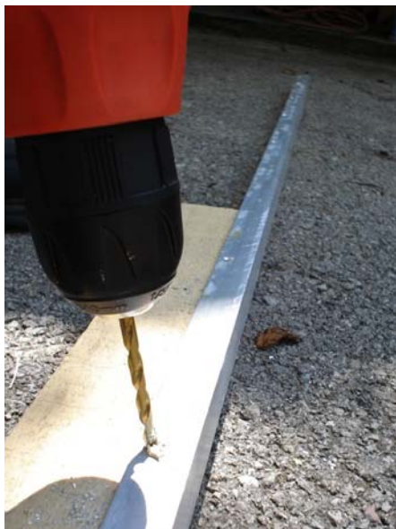
Slika 4.39. Priprema rupa za zavrtnje u ivicu panela
