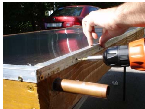
Slika 4.43. završna montaža L-profila
