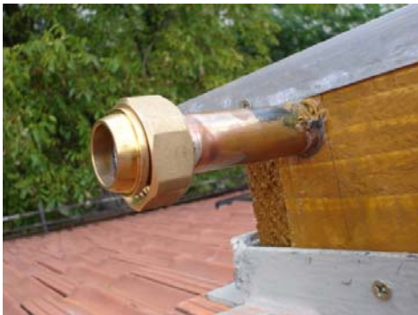
Slika 5.9. Holender na izlaznoj cijevi
