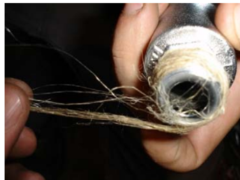
Slika 5.12. Montiranje ozračnog ventila
