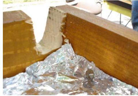
Slika 4.33. Izlaz/ulaz za cijevi izvan solarnog panela
