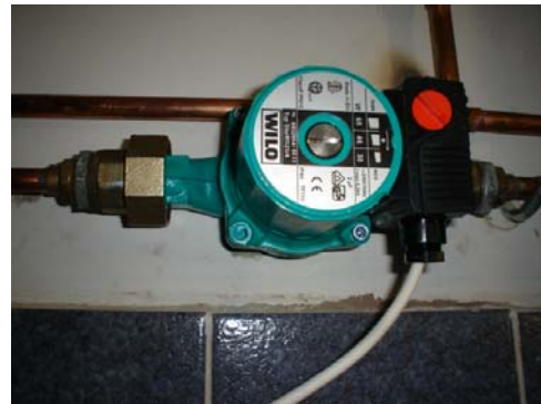
Slika 5.25. Trobrzinska niskoenergetska pumpa
