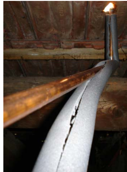
Slika 5.31. Montiranje izolacije na cijevi
