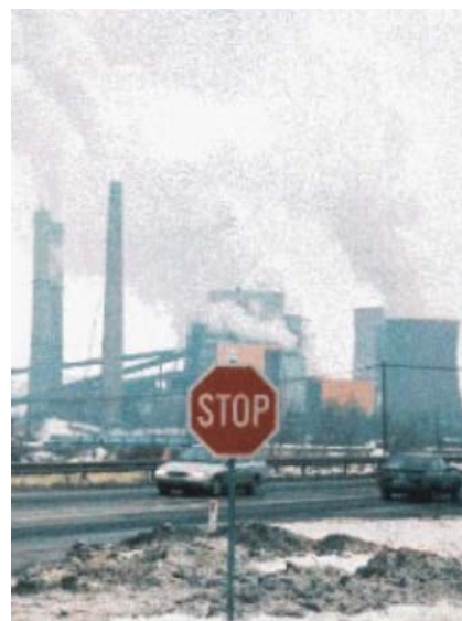
Slika 1.2. Pogled na termoelektranu Tuzla
