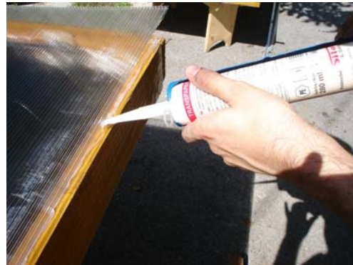
Slika 4.41. Priprema za lijepljenje polikarbonatne ploče
