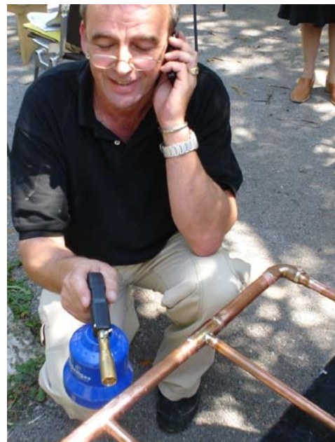
Slika 4.14. Lemljenje sa plamenikom
