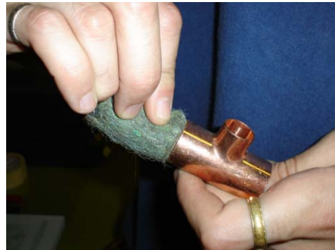
Slika 4.13. Čišćenje fittinga žičanom vunom
