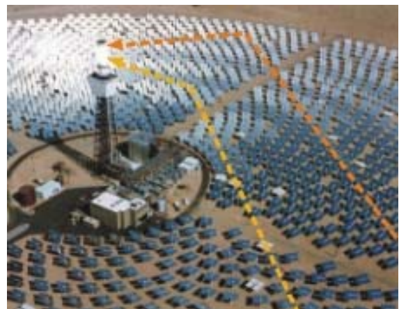
Slika 3.27. Solarna elektrana sa rotirajućim ogledalima
