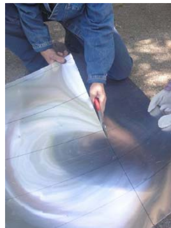
Slika 4.22. Rezanje bakarnog lima prema mjerama
