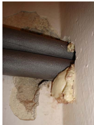
Slika 5.32. Zaprivanje neuglednih rupa pur pjenom
