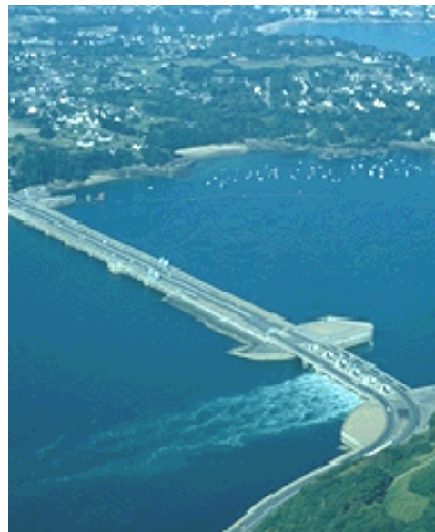
Slika 3.5. Hidroelektrana na principu plime i oseke
