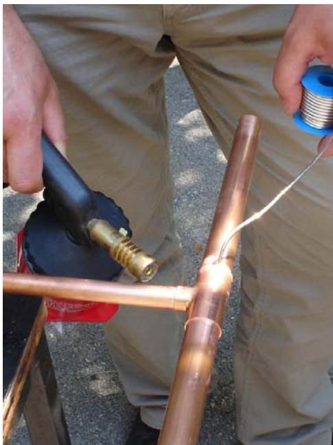
Slika 4.16. Kalaj za lemljenje se dodaje samo sa gornje strane i sam razliva
