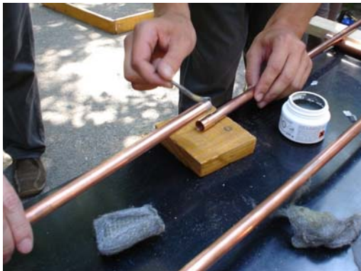
Slika 4.15. Nanošenje paste na cijevi i fittinge
