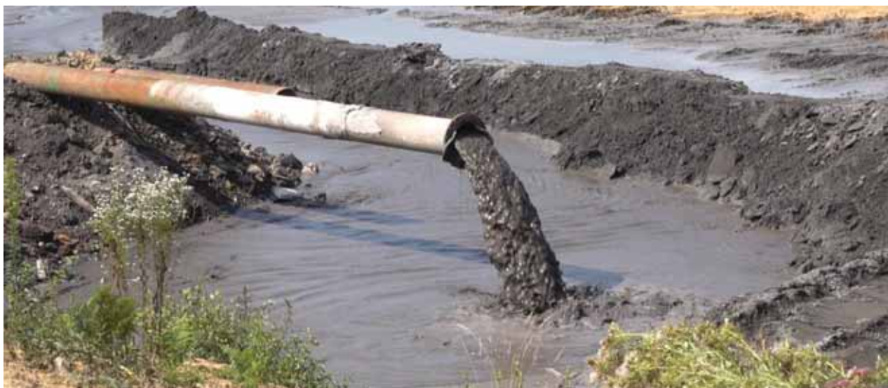
Slika 3.4. Deponija Jezero 2 hidraulički transport šljake i pepela iz termoelektrane Tuzla
